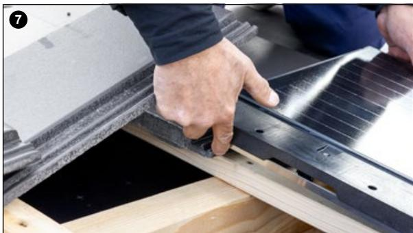
Solarziegel ablegen und unter den rechten oberen Ziegel schieben.
