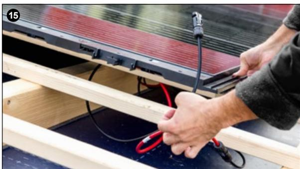
Auslegungsbericht regelmässig prüfen und weitere Module verlegen. **Vorsicht:** Prüfen, welches Kabel jeweils zum nächst oberen Ziegel geführt wird.
