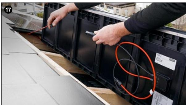
Kabel der obersten Solarziegel-Module korrekt miteinander verbinden.
