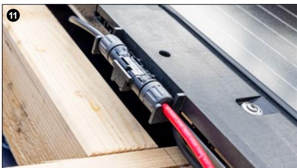
Stecker in die dafür zur Verfügung stehende Halterung einsetzen. Falls die Stecker nicht hineinpassen, Steckerverbindung nochmals prüfen.
