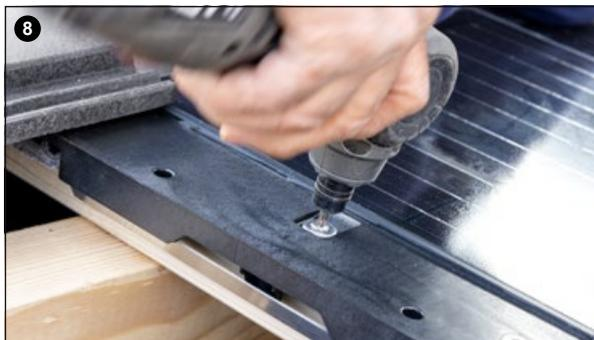
Solarziegel anschrauben, 3–5 Schrauben, je nach Windexposition.
