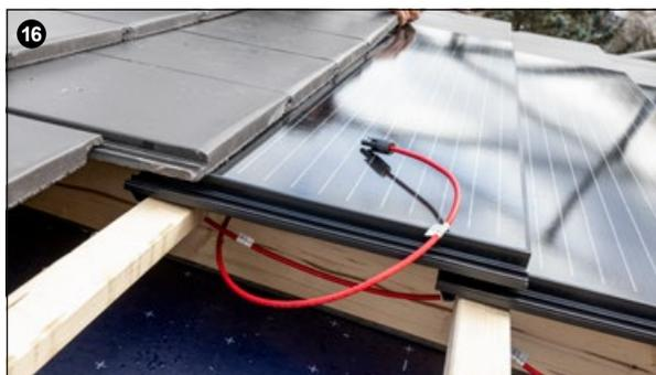
Beim letzten Solarziegel das zweite Kabel seitlich wegführen. Die oben angrenzenden Ziegel können bereits verlegt werden oder erst bei Abschluss der Solarziegel-Installation.
