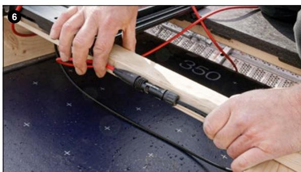
String-Kabel-Verbindung mit Kabelbinder an Ziegellatte fixieren.
