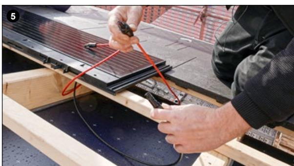
Solarziegel-Kabel mit dem String-Kabel, das vom Technikraum hochgeführt wurde, anschliessen. Auf Polarität achten!
