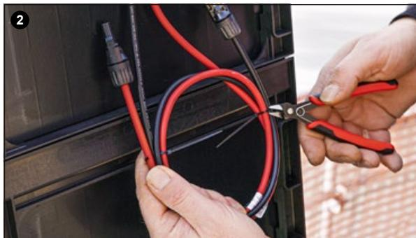
Kabelbinder mit Hilfe einer Zange entfernen. Vorsicht: Isolationen nicht beschädigen!
